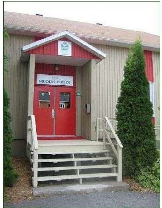
salle Nicolas-Perrot, Bécancour photo: Chantal Perreault
